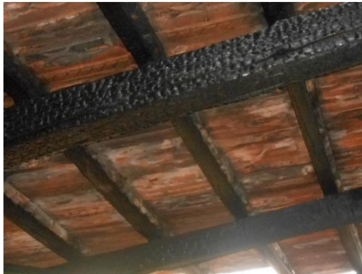
Slika 4. Tragovi krokodilske kože (Karbonizirani rogovi i letve krovišta) [8]
