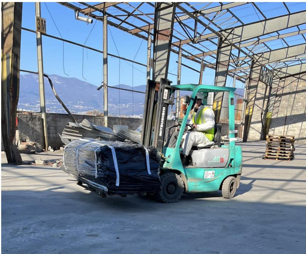
Slika 7. Priprema materijala (otpada) koji sadrži azbest za odvoz sa gradilišta [2]
