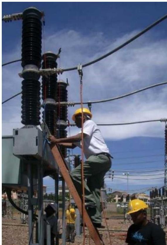
Slika 28. Ispitivanje prekidača uzemljenja [21]
