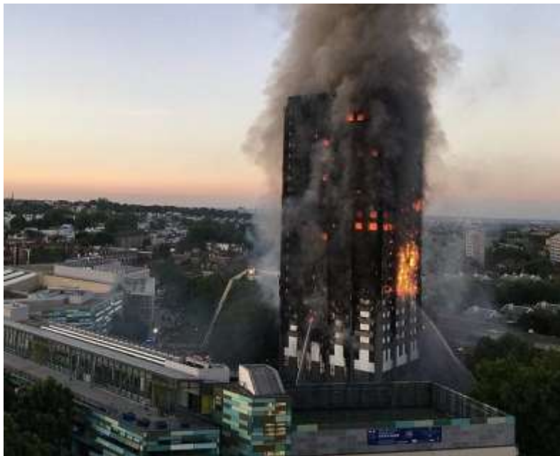
Slika 9. Požar u Grenfell Toweru [16]
