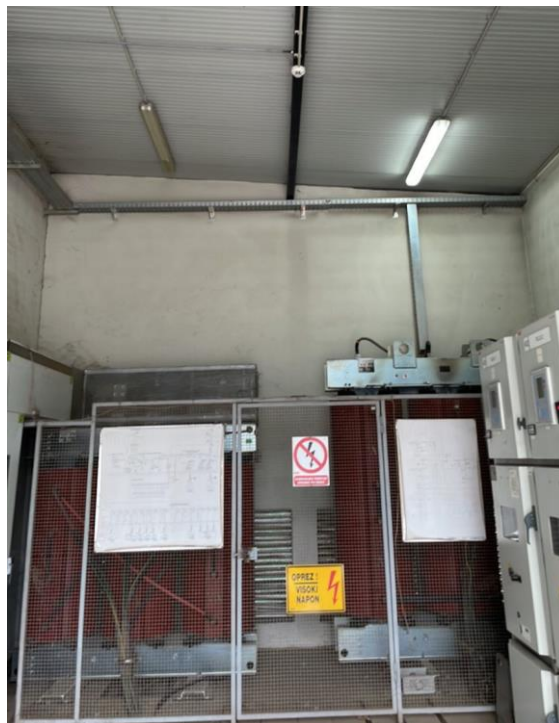
Slika 27. Optički javljač u rasklopištu [5]
