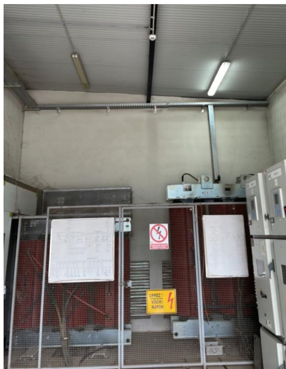
Slika 27. Optički javljač u rasklopištu [5]
