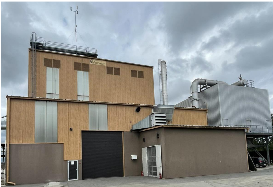
Slika 3. Kogeneracijsko postrojenje tvrtke "Strzivojna-Hrast d.o.o." [5]
