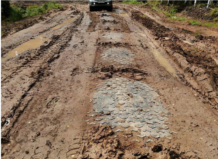
Slika 18. – prikaz isotrack H modela na šumskim kolotrazima
