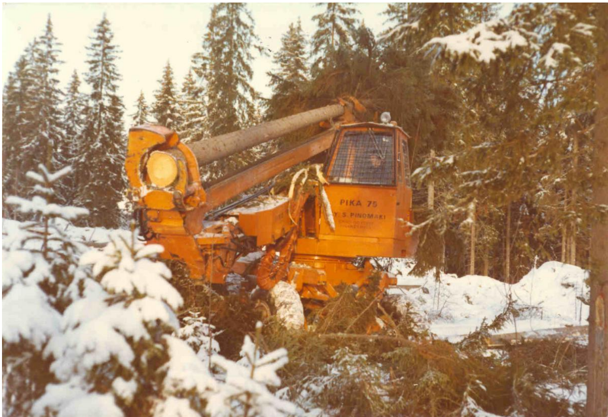
Slika 4. – Prvi harvester, model PIKA 75
