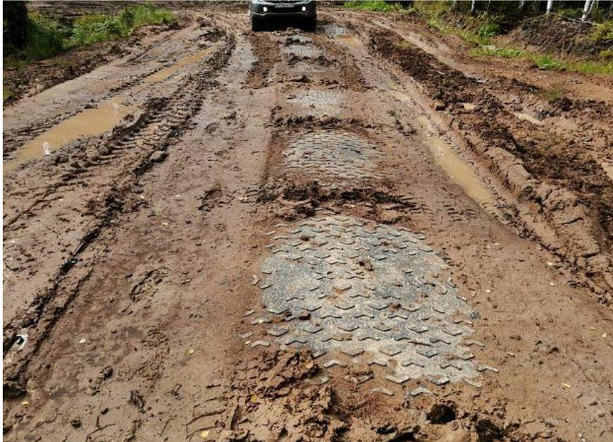
Slika 18. – prikaz isotrack H modela na šumskim kolotrazima
