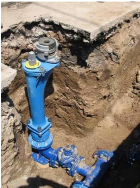
Slika 14. Podzemni hidrant [8]
