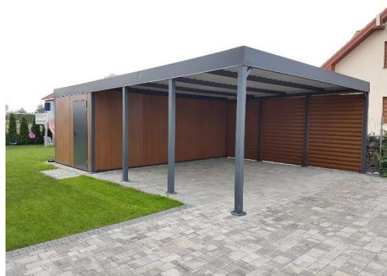
Slika 2. Konstrukcija zatvorenog profila cijevi [2]
