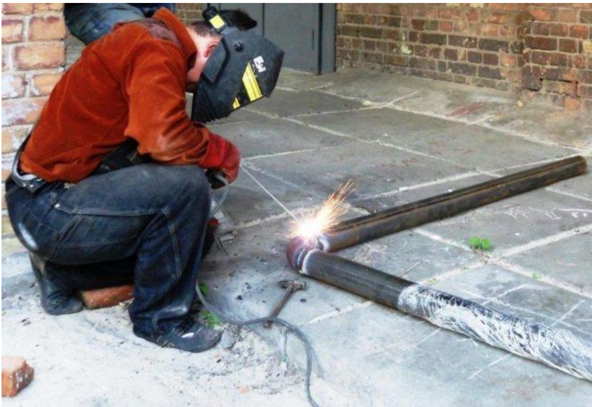
Slika 4. Nepovoljan položaj tijela pri zavarivanju cijevi
