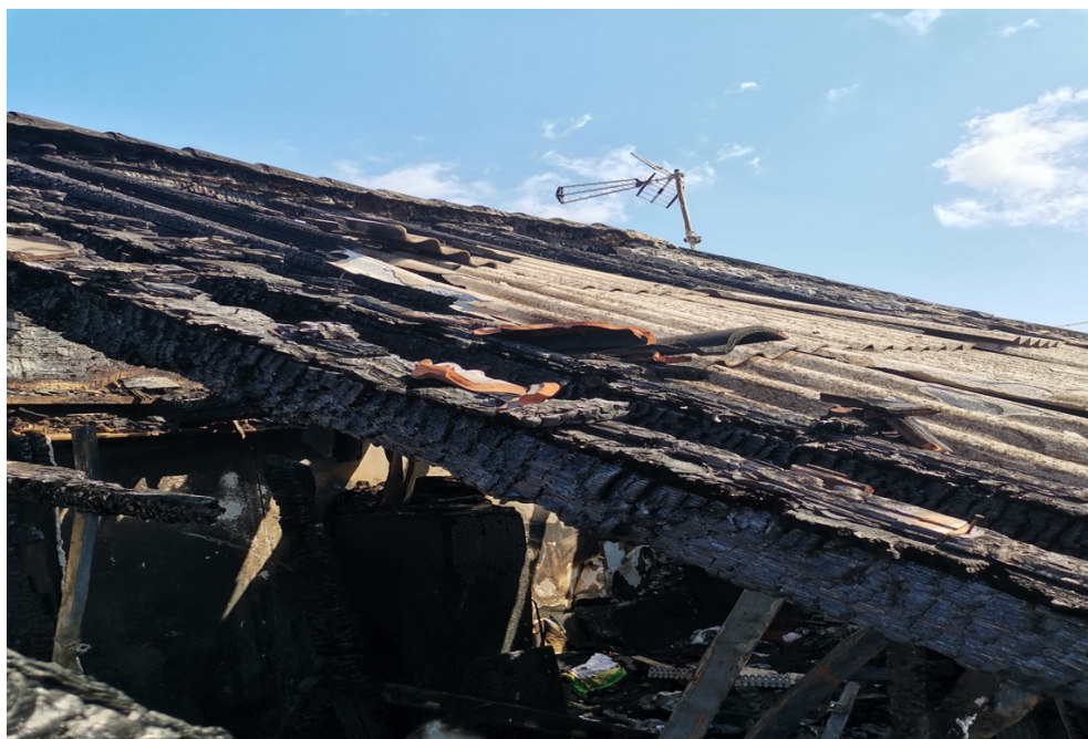
Sl. 23. Sanacija dan nakon požara.[4]
