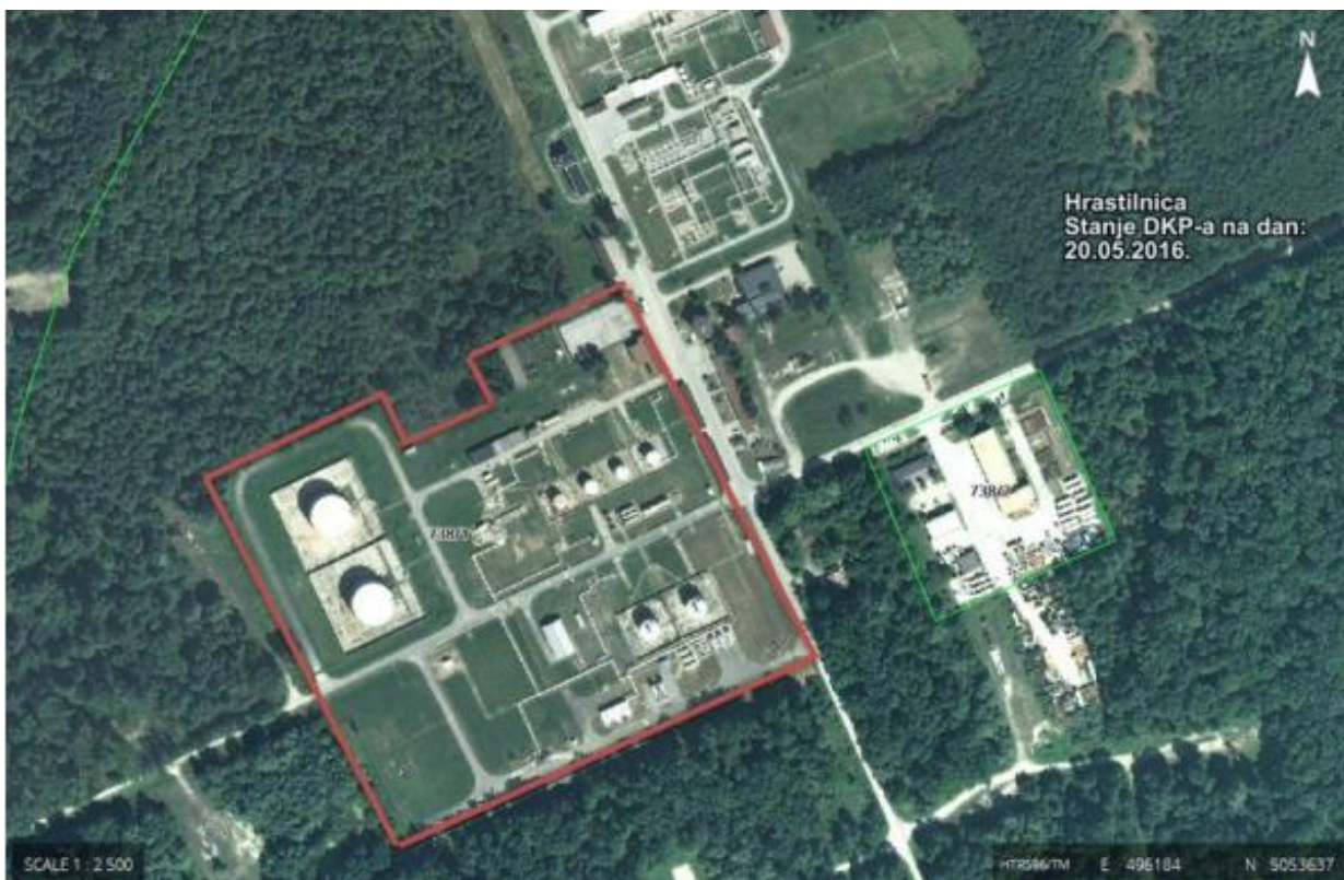
Slika 6: Lokacija otpremne stanice Žutica (Izvor: http://geoportal.dgu.hr/ )
