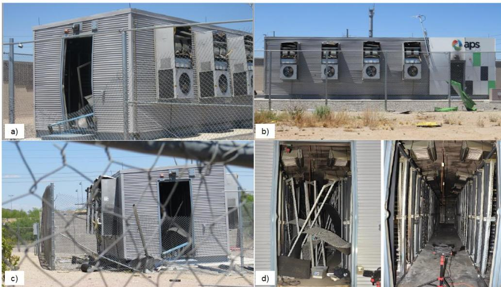
**Slika 18.** Prikaz postrojenja McMicken BESS-a nakon eksplozije, pod a) oštećenje stražnjih vrata i HVAC sustava, b) izbačena bočna vrata, c) krhotine i oštećenja stražnjih vrata i d) unutarnje oštećenje sustava [28]
