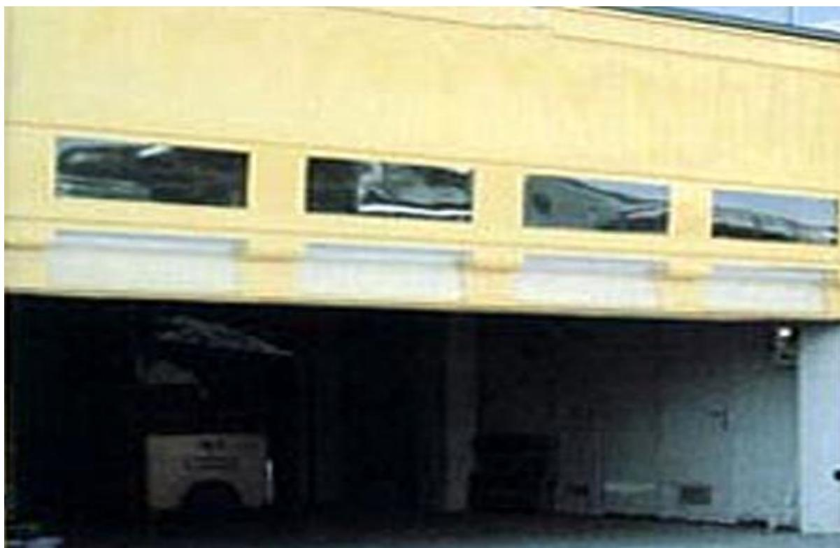
Slika 1. Primjer brzo podiznih vrata na preklapanje [1]
