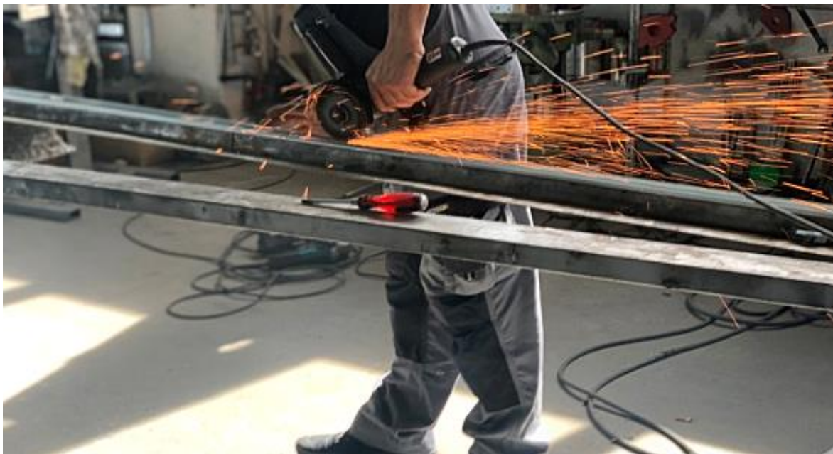
Slika 27. Primjer zavarivanja lamele
