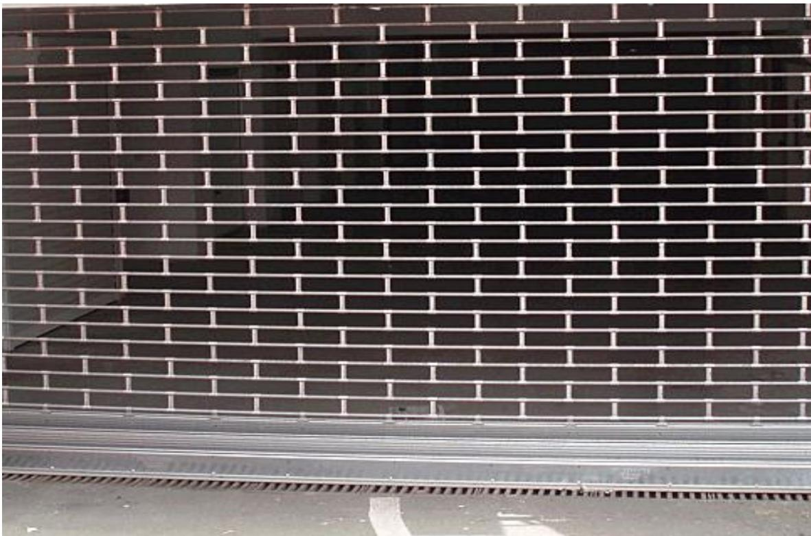
Slika 12. Primjer rolo vrata tip tub [1]
