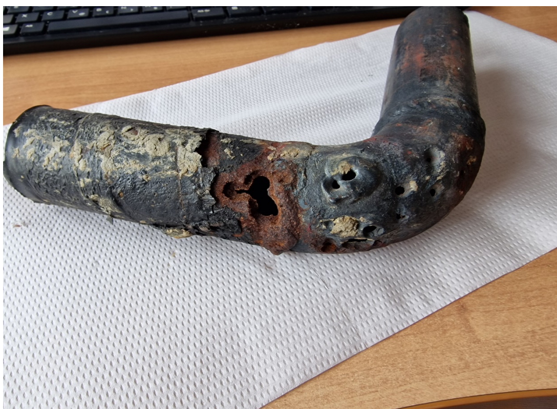
Slika 5. Korozijska šupljina na plinovodu bez katodne zaštite nakon samo nekoliko godina
