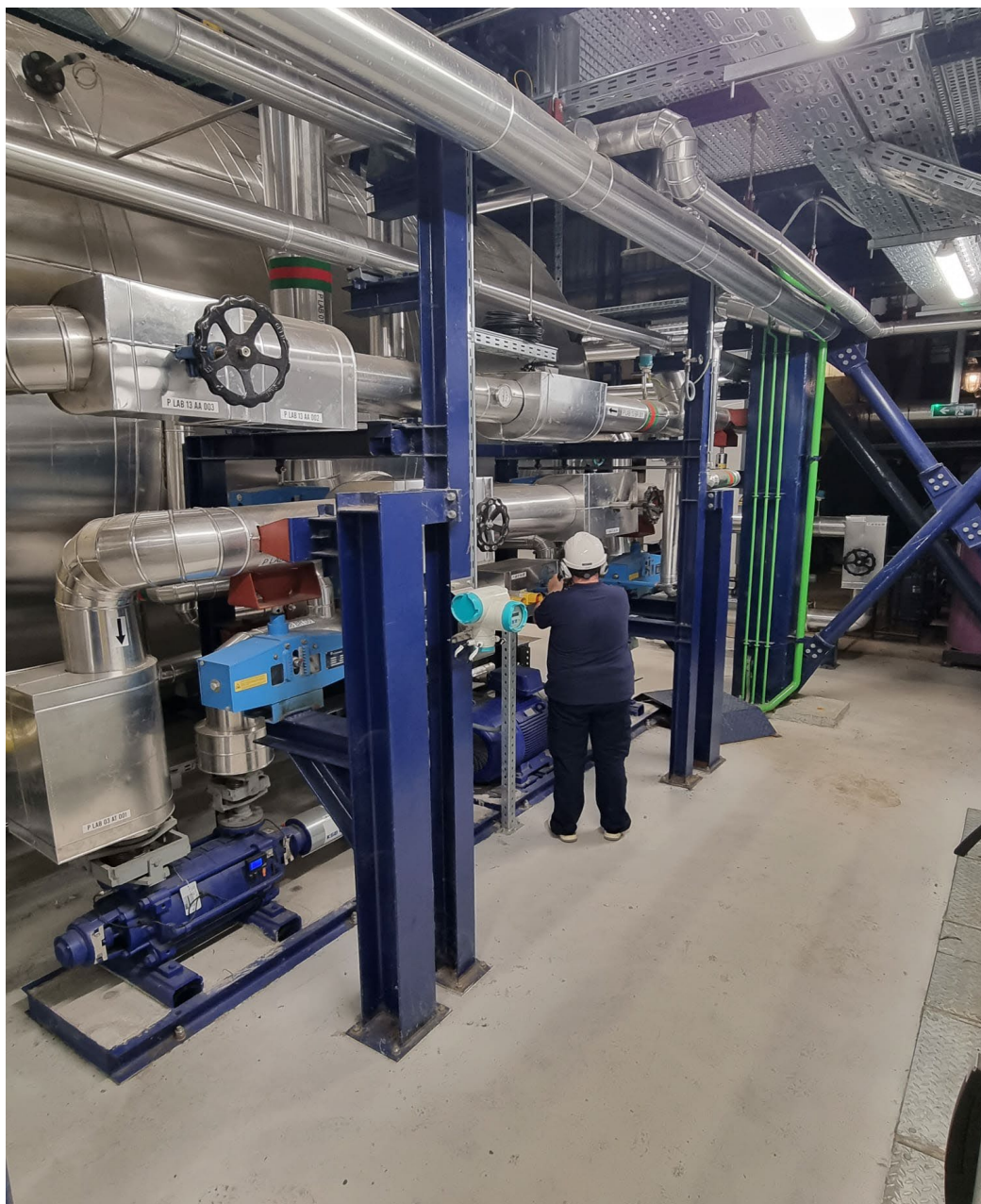
Slika 7. Niskotlačni kotao NTK3 [11]
