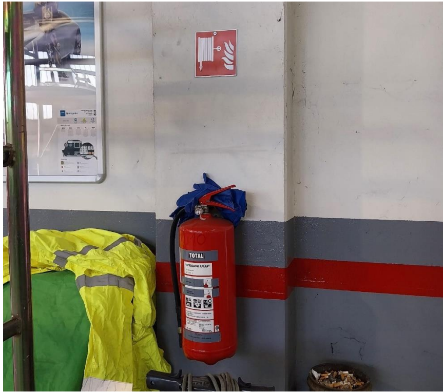
Slika 9. Vatrogasni aparat sa prahom [16]
