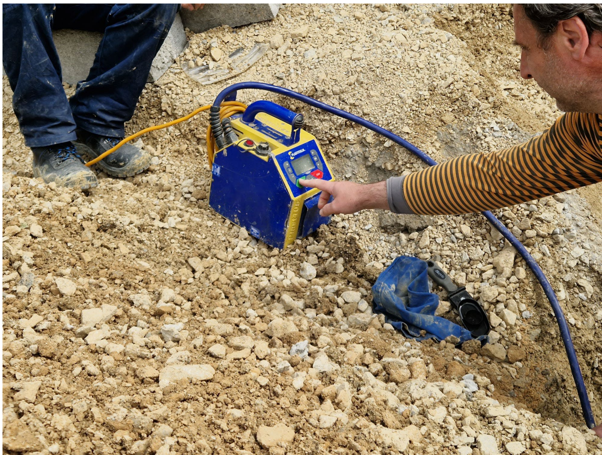
Slika 39. Pokretanje kontrolne jedinice [Izvorno autor]
