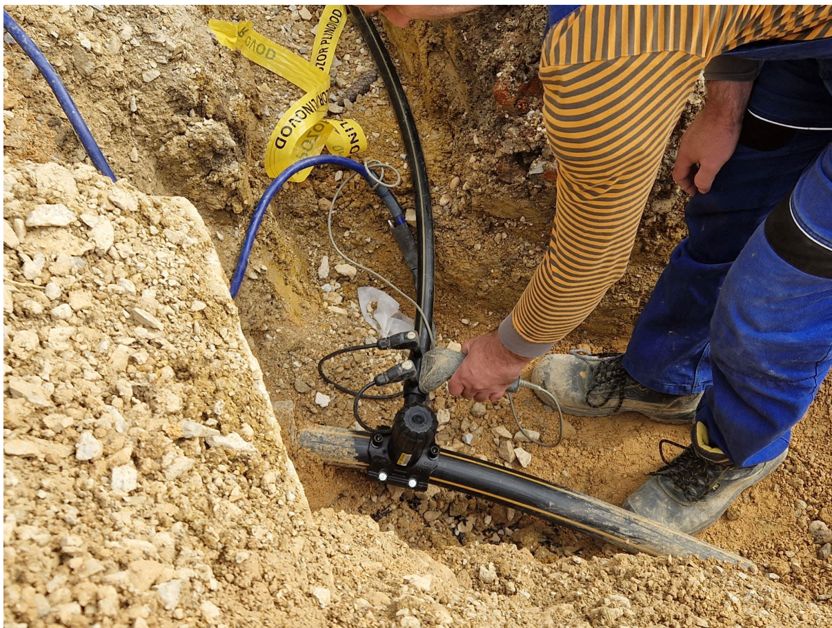
Slika 38. Učitavanje parametara s elektrofuzijske spojnice [Izvorno autor]
