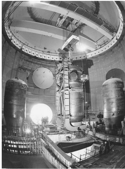
Slika 8 Ugradnja oba parogeneratora[11]
