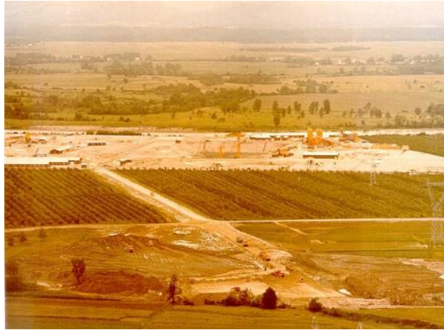
Slika 4 Početak građevinskih radova[11]
