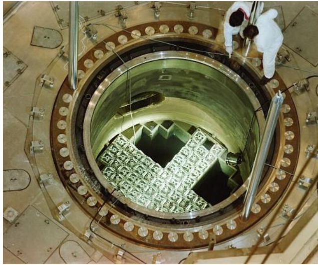
Slika 10 Ubacivanje goriva u reaktorsku posudu[11]
