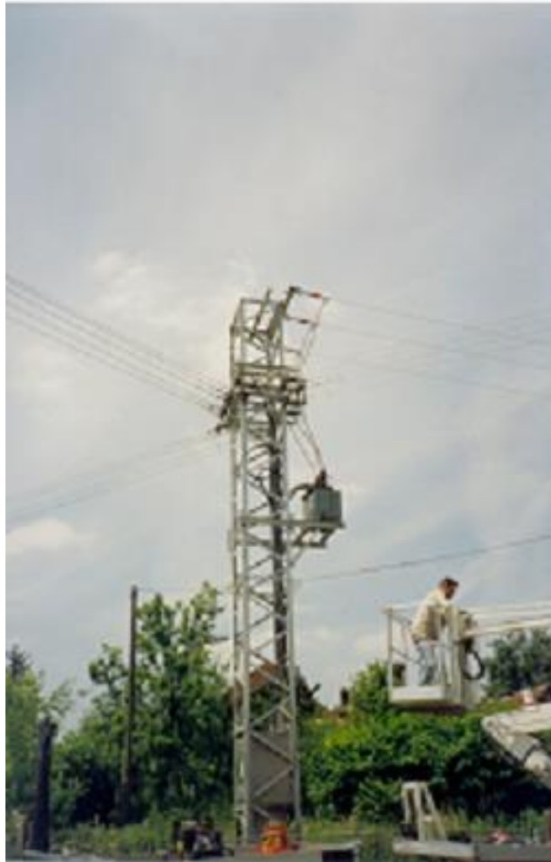
Slika 2: Elektroenergetski nadzemni vodovi i trafostanica
