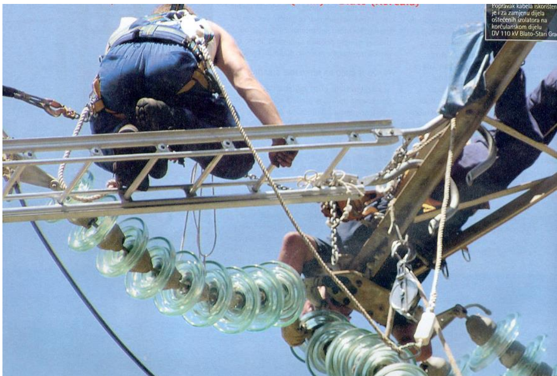
Slika 21: Prikaz zamjene izolatorskog lanca na dalekovodnom stupu
