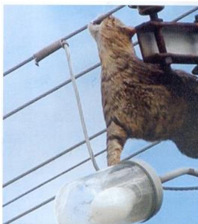
*Slika 15: Prikaz dozemnog spoja izazvan mačkom*
