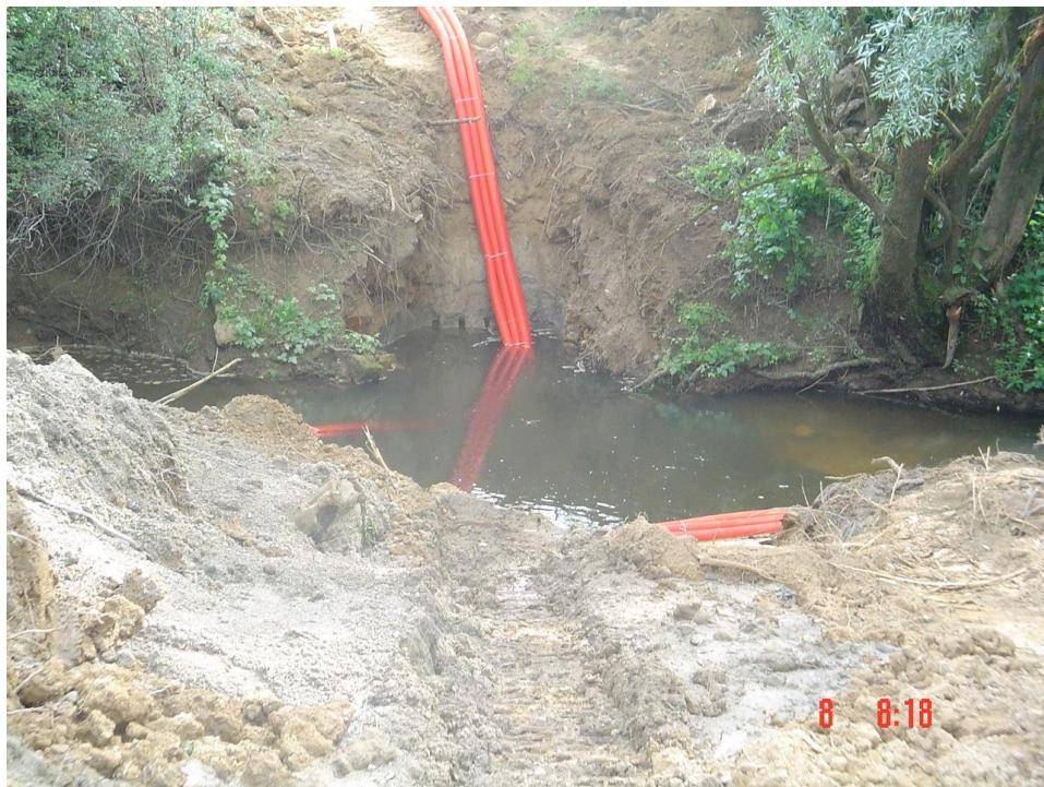
Slika 4: Elektroenergetski kabelski vod (prelaz preko potoka)
