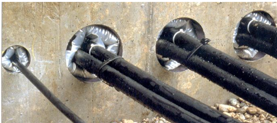
Slika 25: Prikaz zaštite prolaza kroz uvedne kanale trafostanice
