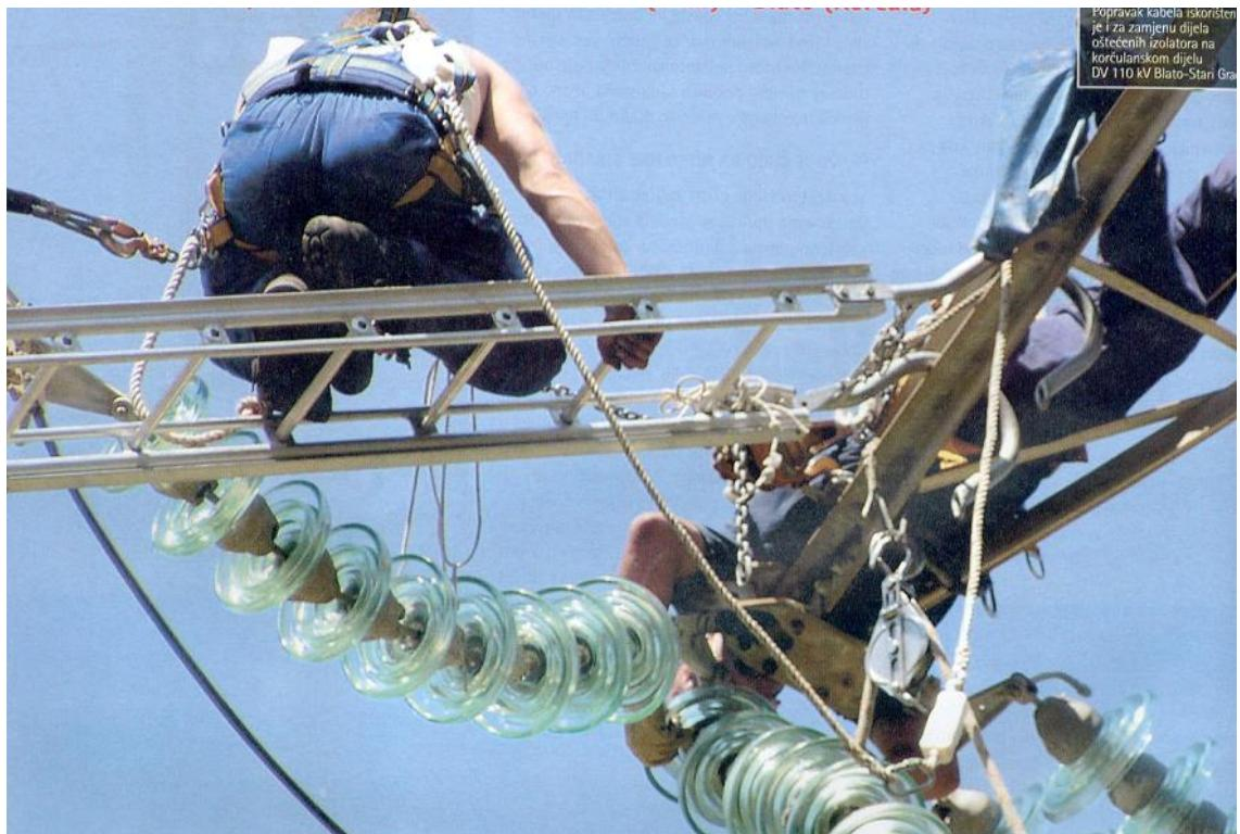
Slika 21: Prikaz zamjene izolatorskog lanca na dalekovodnom stupu
