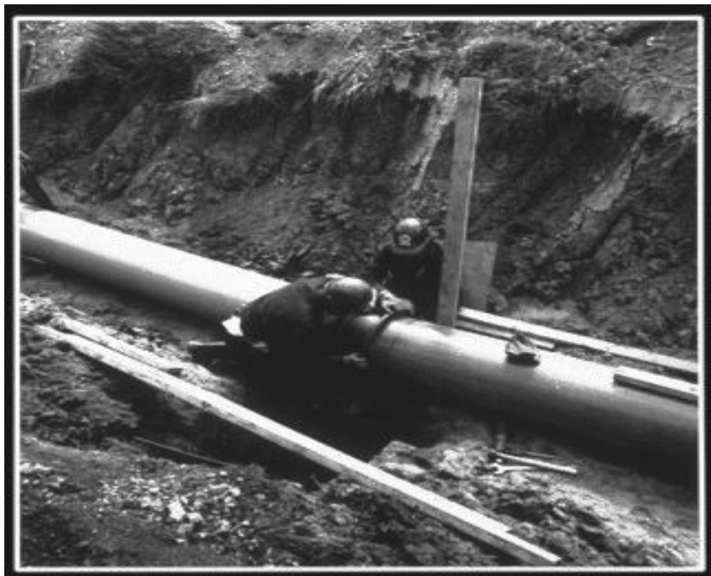
Slika 2: Postavljanje cijevi od 18" , Varennes, Québec, 1967. [3]
