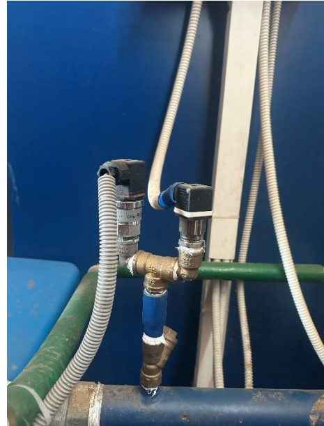
Slika. 10 Montiran senzor tlaka Izvor: Autor
