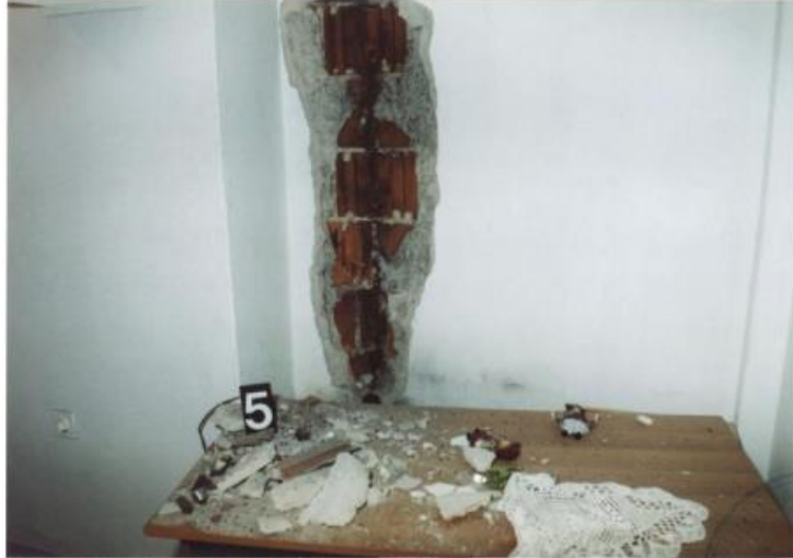
Slika 15. Podžbukno preopterećenje strujnog kabela [24]
