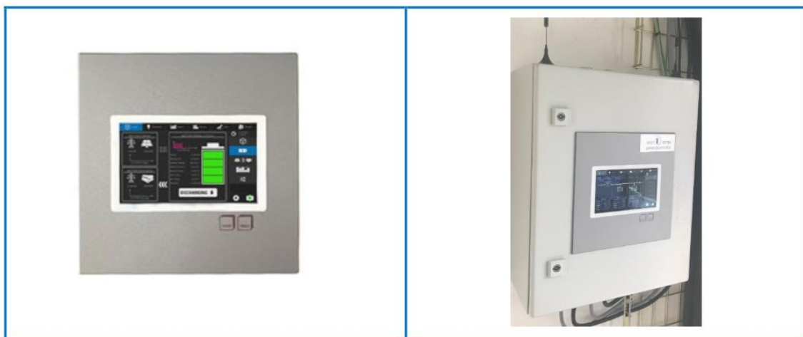
Slika 22. Izvedba kontrolera u strujnom ormaru
