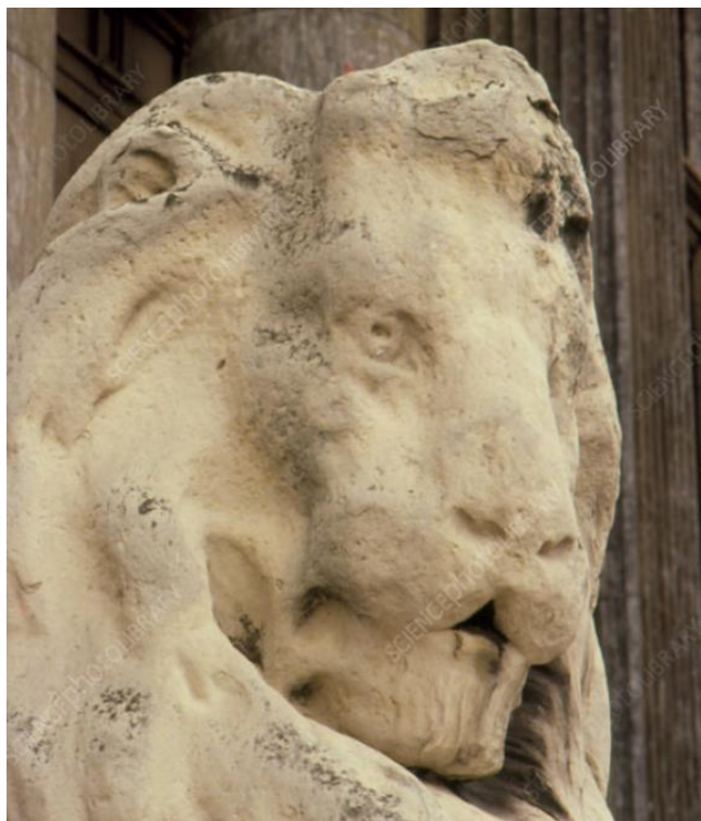
Slika 1. Kameni kip erodiran utjecajem kisele kiše. [2]
