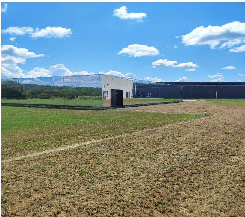
Slika 17: Ulaz u Sprikler stanicu
