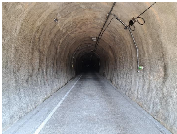
Slika 10. Unutrašnjost servisne cijevi tunela Sv. tri Kralja [11]
