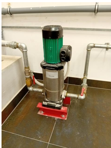
Slika 48. Pumpa za održavanje tlaka u sustavu [21]
