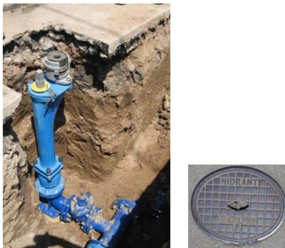
Slika 40. Podzemni hidrant [18]
