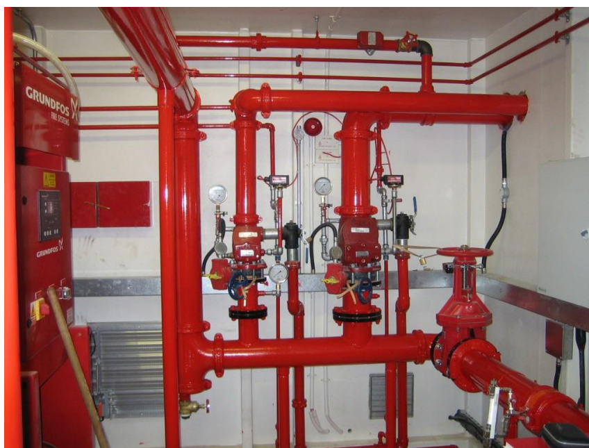
Slika 33. Drencher sustav sa deluge ventilom [16]
