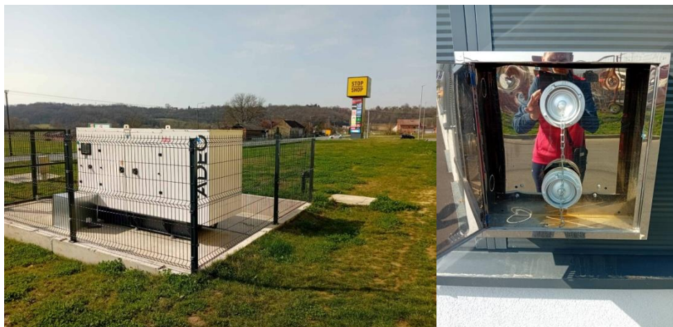
Slika 46. Podzemni akumulacijski spremnik (lijevo), priključak za vatrogasno vozilo sprinkler stanice (desno) [21]
