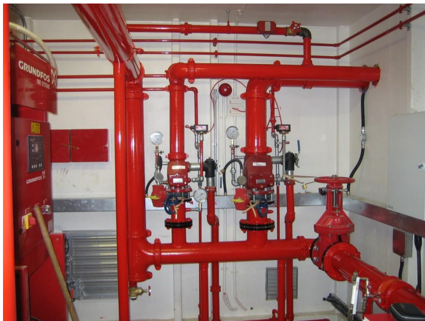
Slika 33. Drencher sustav sa deluge ventilom [16]
