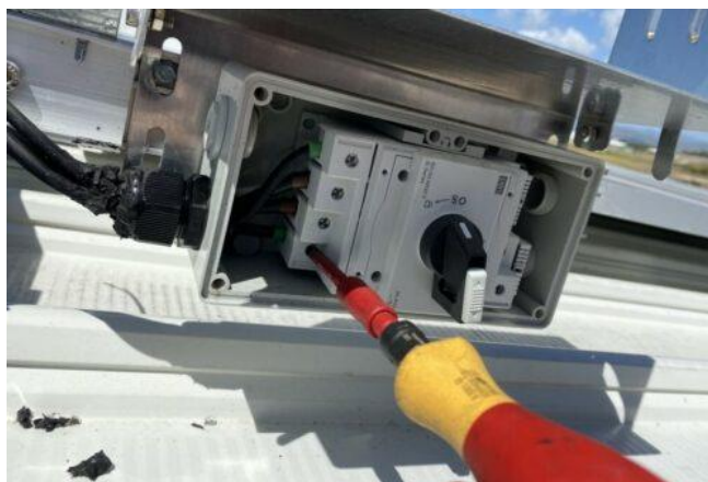
Slika 16. Provjera zategnutosti spojeva vodiča na terminalu [7]
