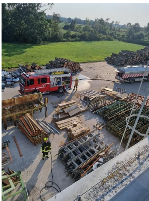
Slika 28. Nepristupan prilaz objektu nagomilanim gorivim materijalom [11]
