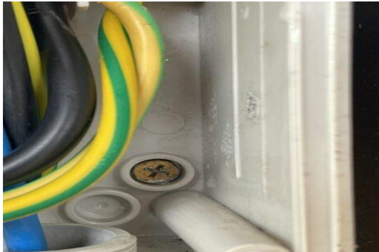
Slika 11. Nakupljena vlaga i korozija na vijku koji nije zatvoren poklopcem ili silikonom [7]
