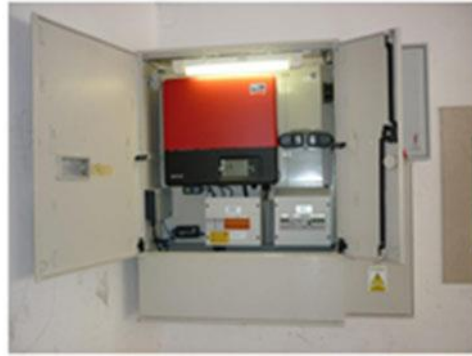
Slika 6. Paralelni izmjenjivač [5]
