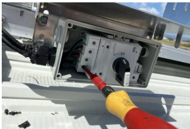
Slika 16. Provjera zategnutosti spojeva vodiča na terminalu [7]
