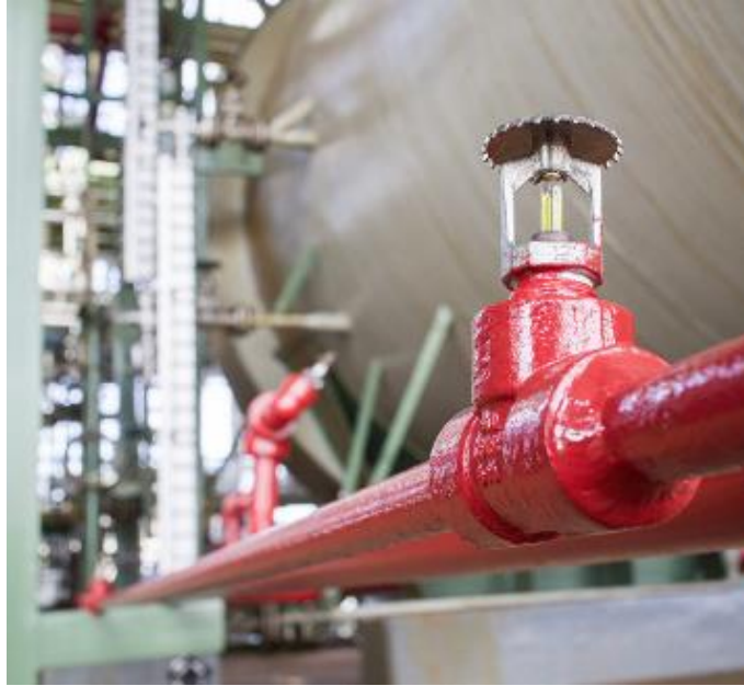
Slika 12. Sprinkler mlaznica [19]
