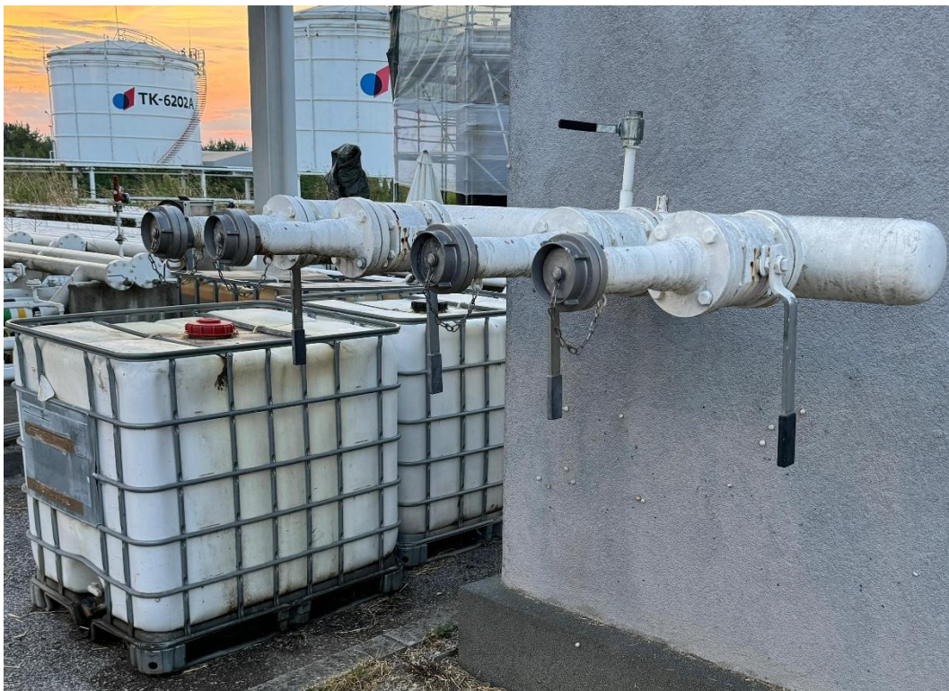
Slika 11. Polustabilni sustav za gašenje požara [19]
