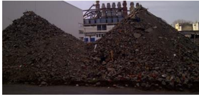
Slika 8. Materijal s nečistoćama dobiven nakon drobljenja [12]
