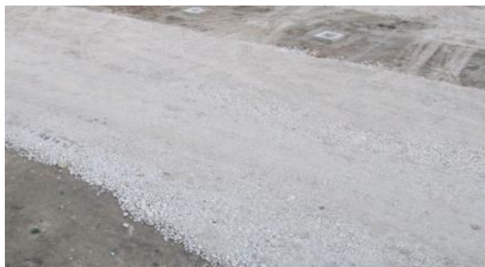
Slika 9. Korištenje recikliranim agregatima [12]
