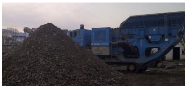
Slika 7. Drobljenje konstrukcijskog betona na licu mjesta [12]
