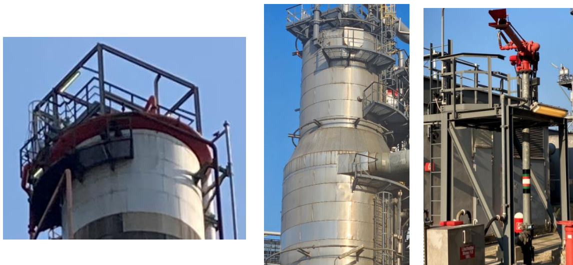
Slika 37. Kolone - različiti sustavi za gašenje požara sa pjenom [1]
