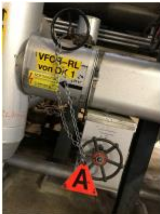
Slika 19. Zaključavanje armatura i ventila [1]
