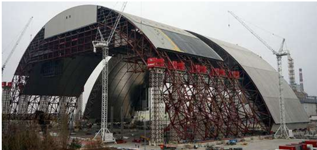
Slika 19: Čelična zaštita iznad reaktora 4 u Černobilu [11].
