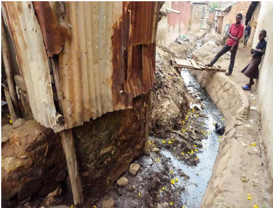
Slika 4. Neadekvatan kanalizacijski sustav
