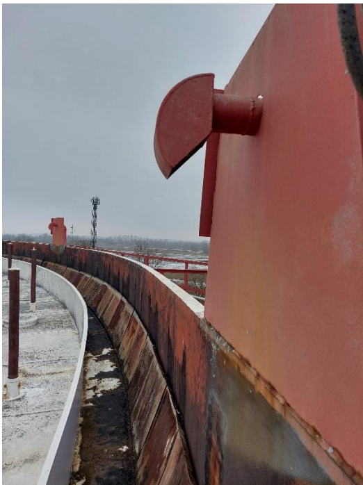
Slika 17. Otvor za ubacivanje pjene [3]
