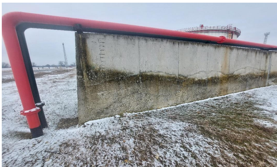
Slika 20. Cjevovod gašenja i hlađenja [3]
