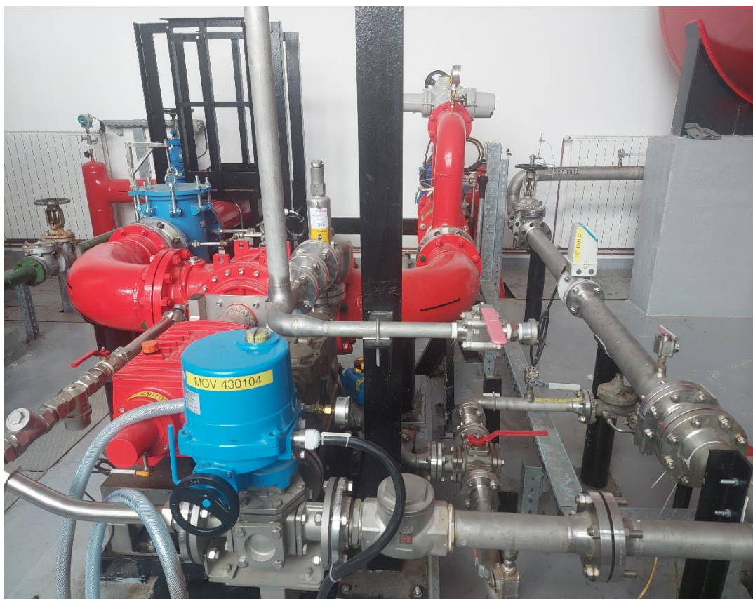
Slika 14. Ulaz vode i pjenila u mješač [3]
