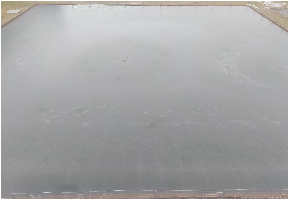
Slika 4. Bazen za protupožarnu vodu [3]
