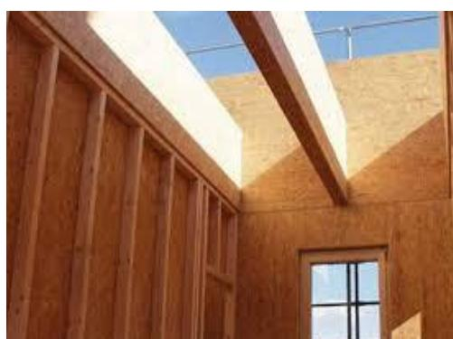
Slika 36. Izrada kuće od kompozitnih ploča [2]
