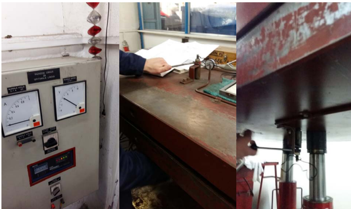
Slika 36. Razvodni ormar za postupak mjerenja limova, te gornji i donji „šiljak“ na pločama preše [9]
