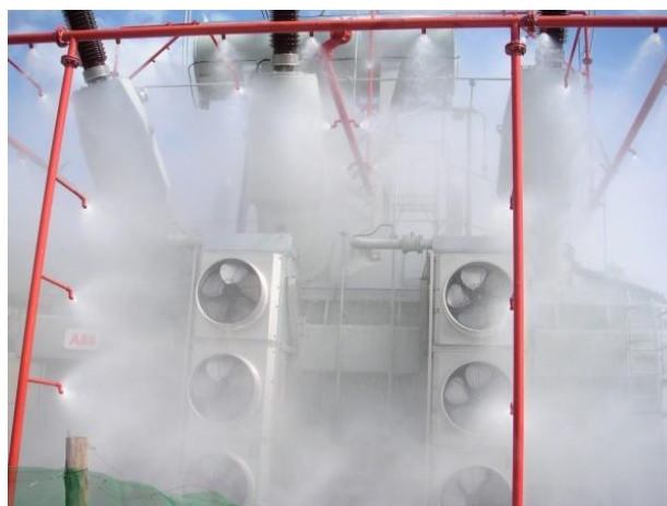
Slika 18. Predodžba Drencher sustava za zaštitu postrojenja
