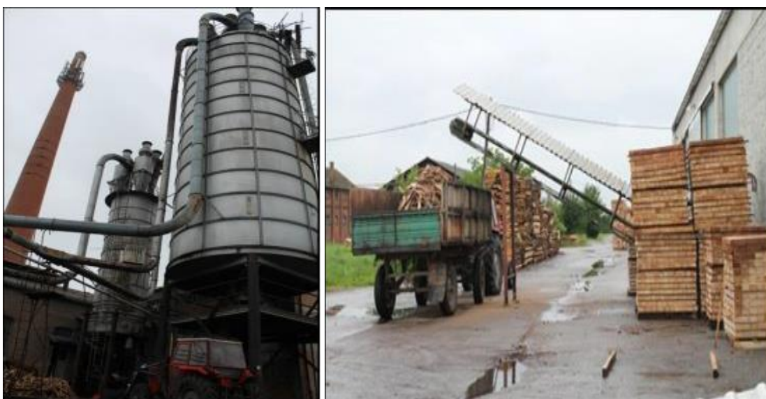
Sl. 29. Silos za drvenu prašinu [1]
