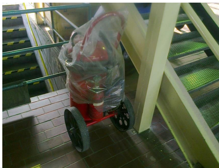
Slika 13. Prijevozni aparat za gašenje s CO 2
