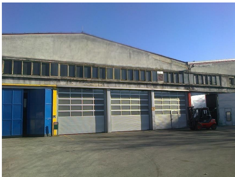
Slika 17. Ulaz u radionicu, glavni objekt
