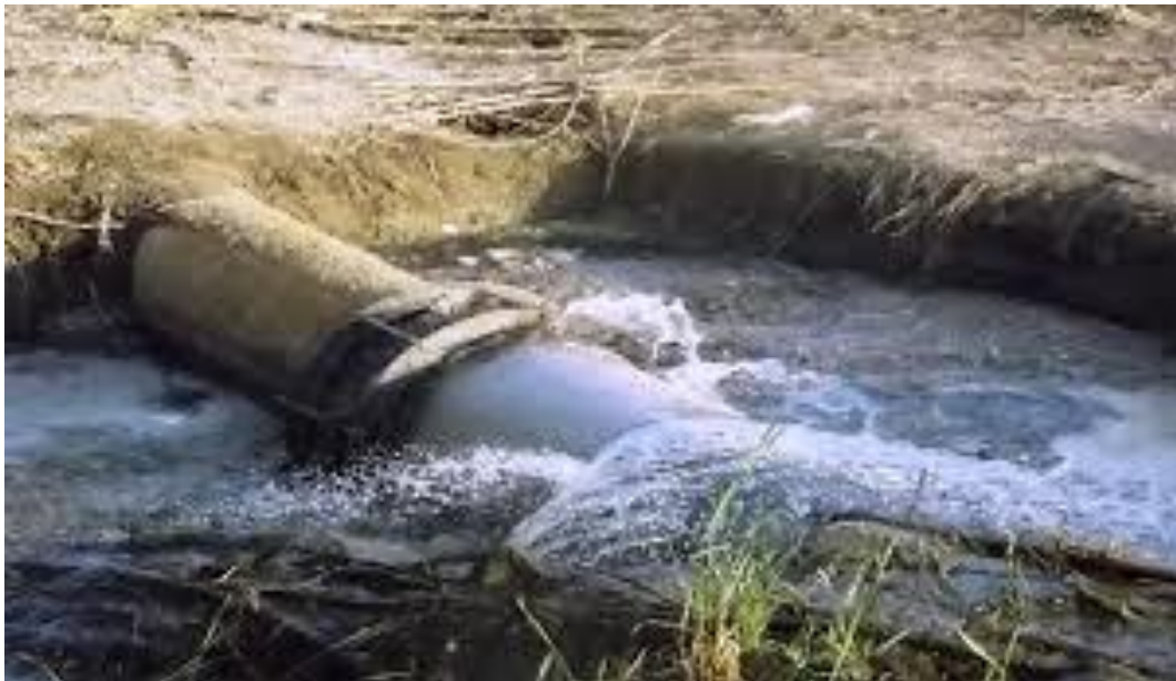
Slika 1. Prikaz neadekvatnih objekata za odvodnju otpadnih voda
