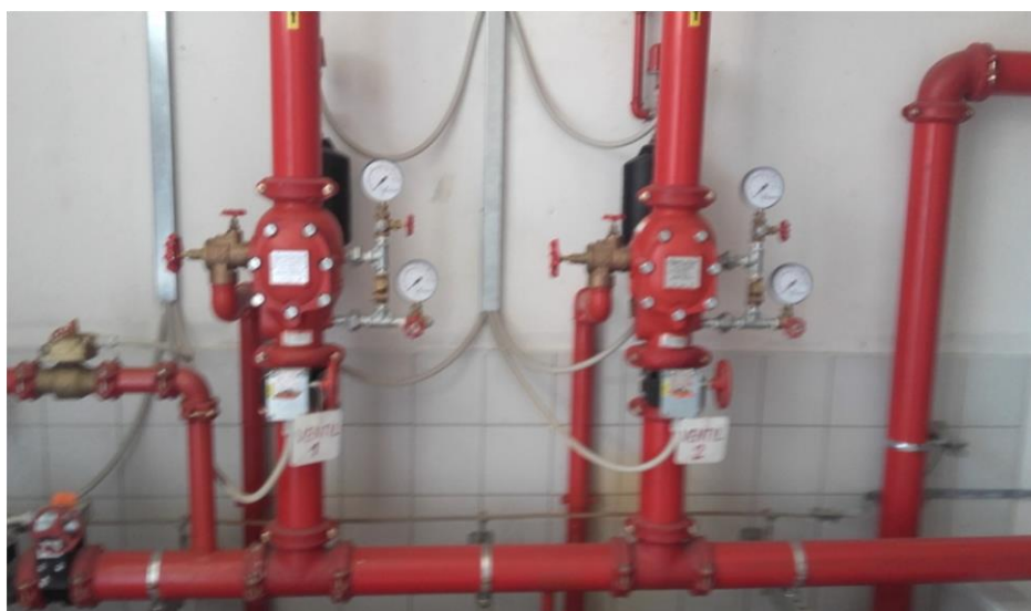
Slika 22. Slinkler instalacija [izrada autora]
