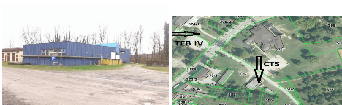
Slika 21. Centralna toplinska stanica.
