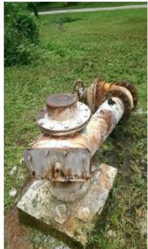
Slika 18. TEB-2 (ne proizvodi), potrebna sanacija ili adekvatno hermetičko zatvaranje bušotine.
