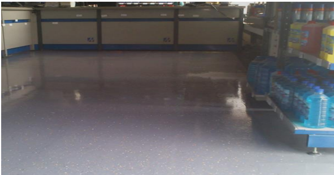
Slika 2. Podna obloga sa epoksidnim premazom i posipom.
