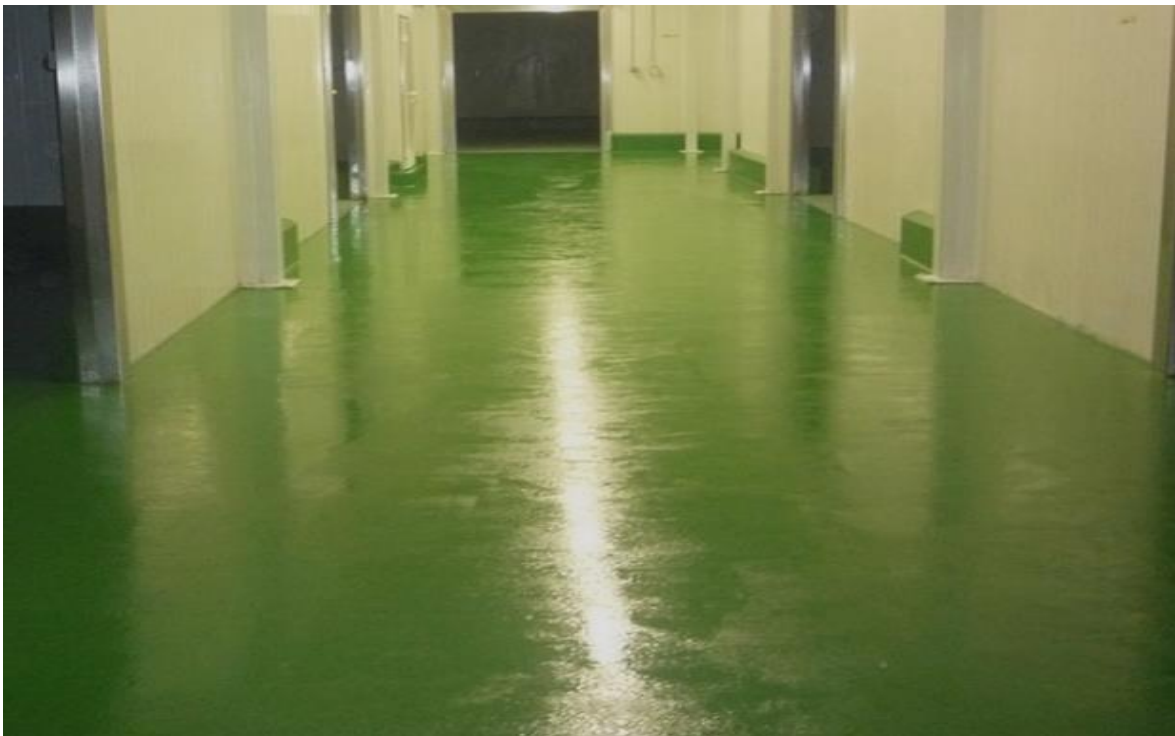
Slika 5. Epoksidni premaz zasićen kvarcnim pijeskom.
