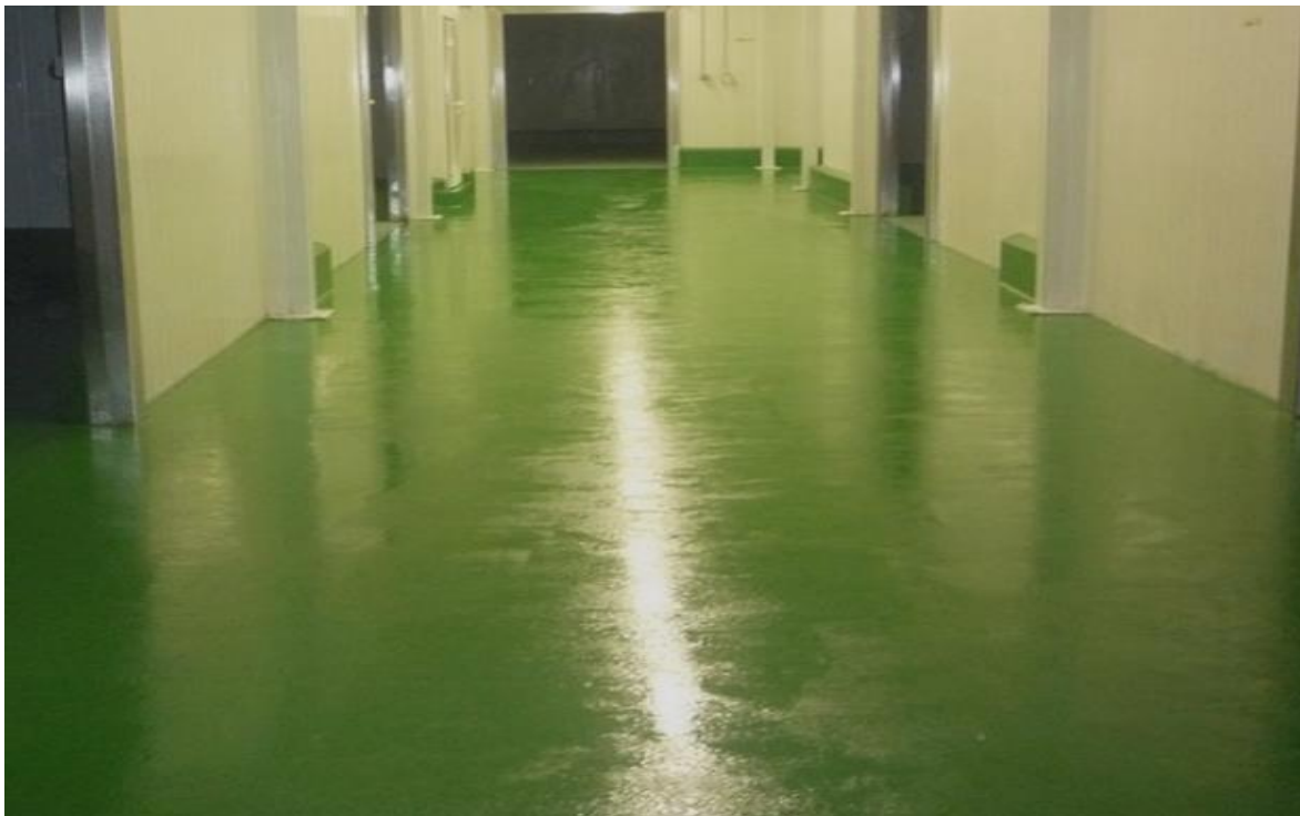
Slika 5. Epoksidni premaz zasićen kvarcnim pijeskom.
