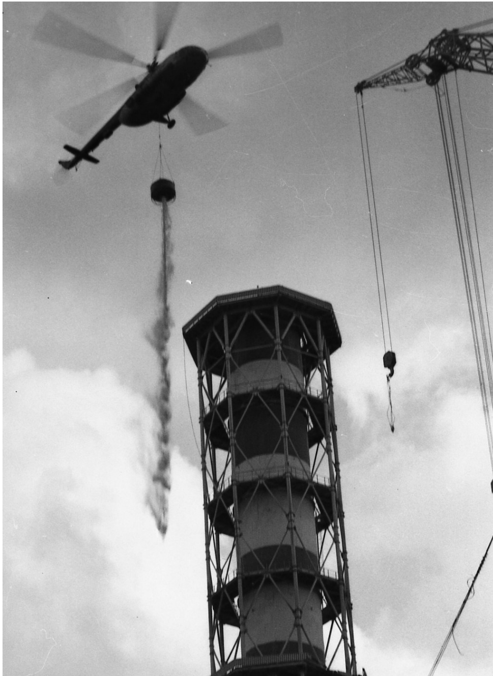
Slika 5. Helikopteri bacaju pijesak, olovo, glinu i neutronske apsorber bor na reaktorsku jedinicu broj 4, gdje je nekada bio krov
