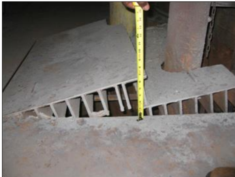
Slika 12. Pomicanje pokrovnih ploča izazvano eksplozijom vodika [14].
