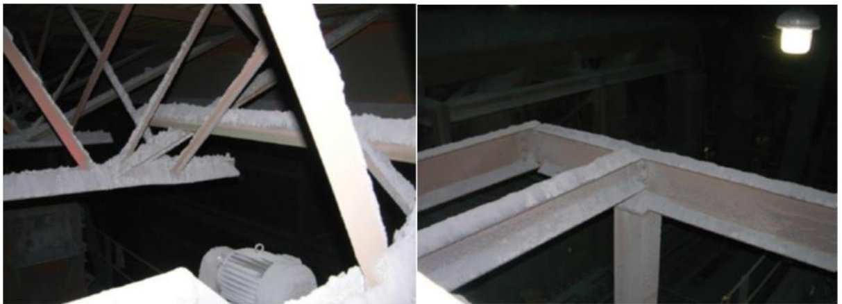
Slika 15. Nakupine praškaste gorive tvari [14].
