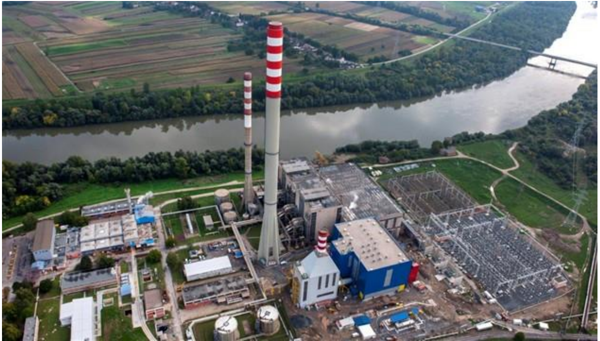
Slika 21: Termoelektrana – toplana Sisak
