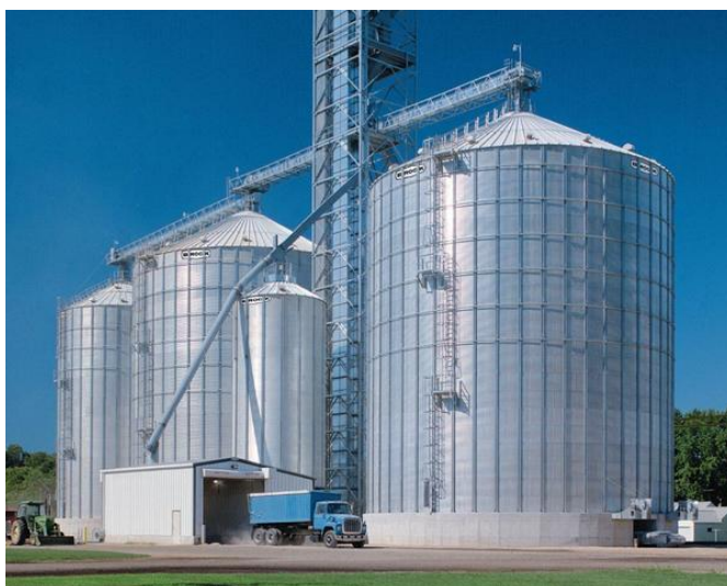
Sl.6. Čelični silos sa 4 komore silosa [7]
