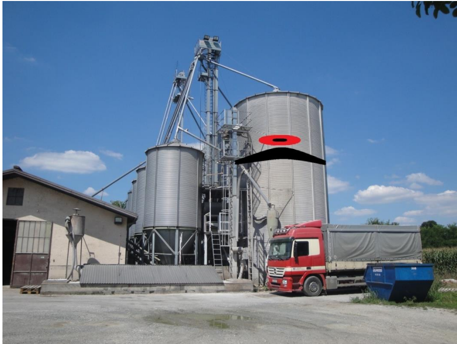
Sl.23. Most krutine ispod žarišta požara [14]
