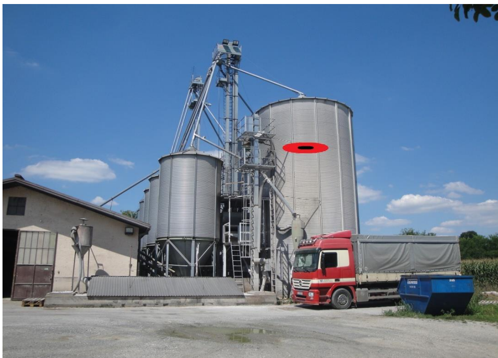
Sl.21. Položaj žarišta požara u komori silosa [14]
