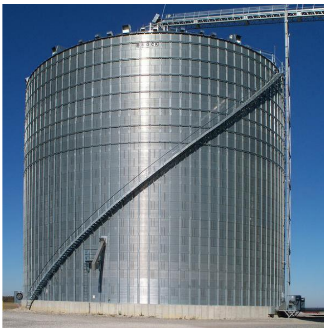
Sl.5. Čelični silos [6]
