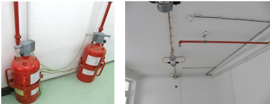
Sl.5 Stabilni sustav za gašenje požara FM 200[16]
