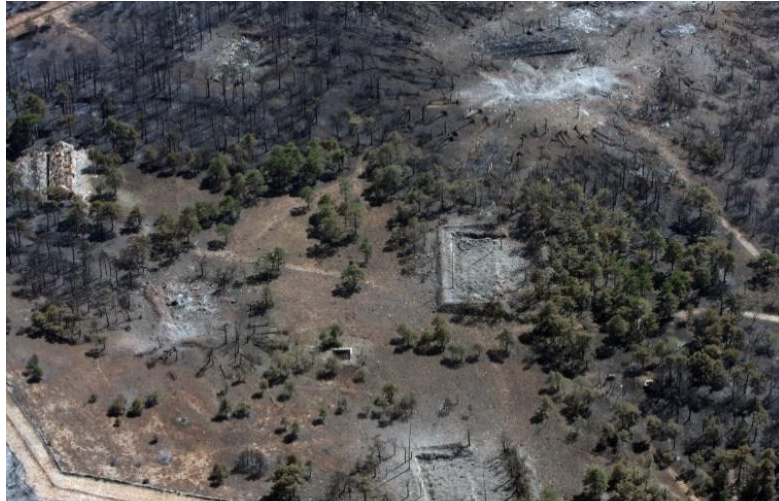
Sl. 13. Skladište ES „Pađene“ nakon požara i eksplozija [23]
