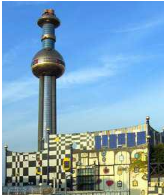
Slika 6. Spalionica otpada Spittelau (Beč, Austrija) [9]
