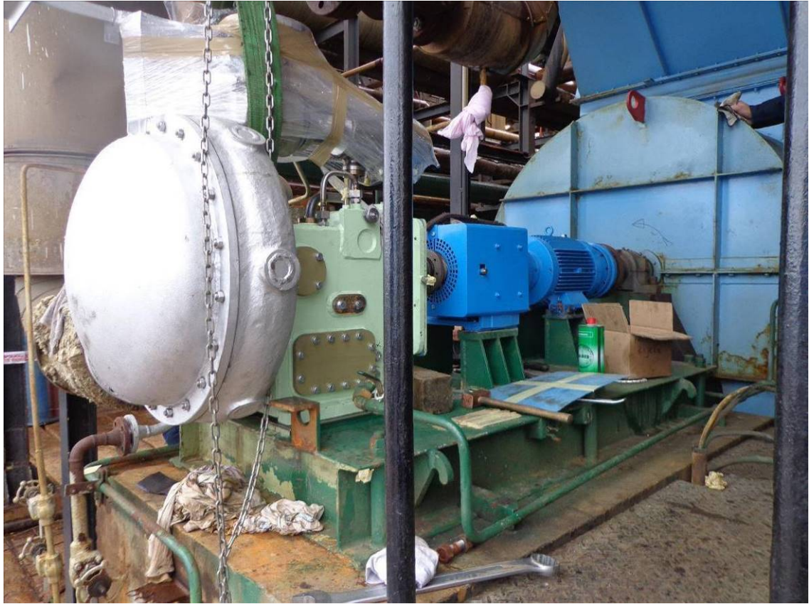
Fotografija 6.3 Montaža turboagregata
